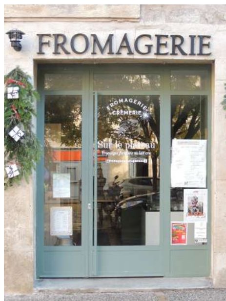
Vitrine en tableau/ coffrage bois
