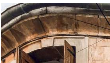
Corniche en pierres taillées servant support de chéneau
