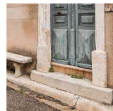
Seuil et marche en retrait du caniveau, en calcaire dur
