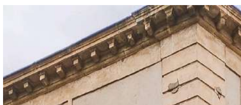
Corniche en pierres taillées intégrant le chéneau (dit chéneau encaissé)
