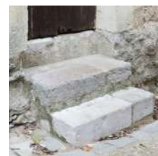
Marches sur le caniveau, en pierre froide
