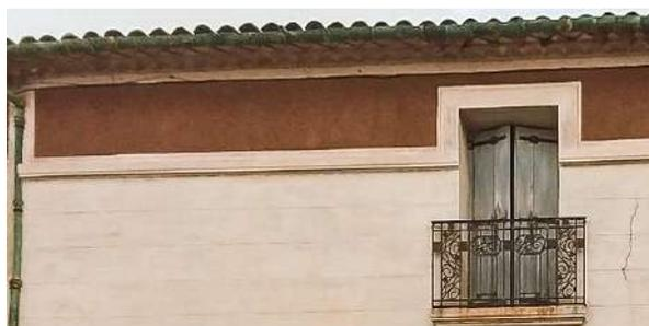
Bandeau large et coloré sous génoises avec enduit à la tyrolienne
