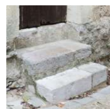
Marches sur le caniveau, en pierre froide
