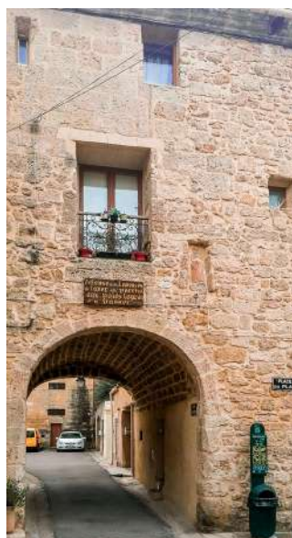
Paroi en moellons à pierres vues
