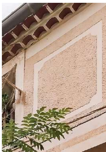
À la tyrolienne sur enduit taloché
