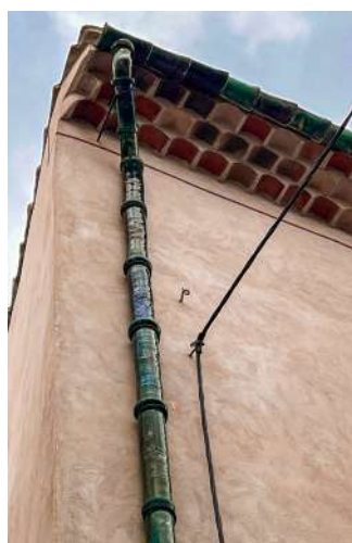
Chéneau et descente en céramique vernissée
