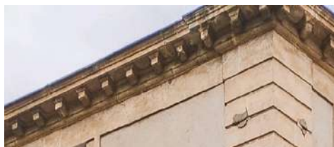
Corniche en pierres taillées intégrant le chéneau (dit chéneau encaissé)
