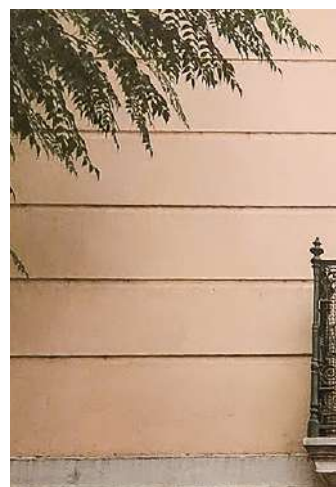
À joints creux
