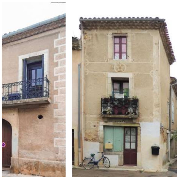
Décors géométriques de teinte claire lissés sur enduit à la tyrolienne, marquant chaîne d'angle, bandeaux horizontaux et verticaux
