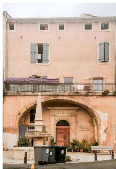
Paroi avec enduit et/ou badigeon
