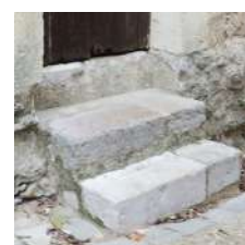
Marches sur le caniveau, en pierre froide
