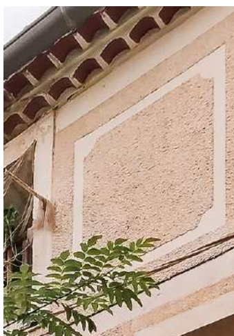
À la tyrolienne sur enduit taloché
